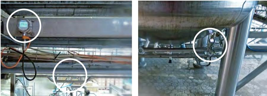
Ingresso: ITM-51 è utilizzato come "sensore remoto". Il punto di misura sul tubo garantisce un ottimo contatto con il prodotto. Per il controllo on-site di facile accesso, il misuratore ha il display montato separatamente.
