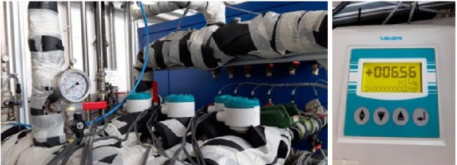
Il cliente doveva misurare la portata di una miscela di acqua e glicole al 50% e aveva avuto un risultato negativo con i misuratori a principio Vortex.
