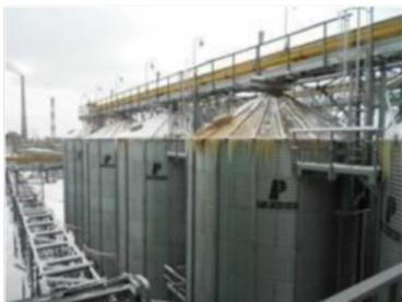
Il cliente è uno dei maggiori produttori di olio vegetale in Siberia. Aveva bisogno di una misura continua del livello per i suoi silos di stoccaggio delle granaglie. Il magazzino è composto da 10 silos a tetto inclinato, ciascuno alto 14 m.
