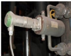
Tipo di interruttore di livello: HAA 01 041 con galleggiante: S021-0RC1
