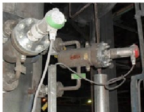
Tipo di interruttore di livello: HAA 22C01 041 con galleggiante: I021-1C0RC1
