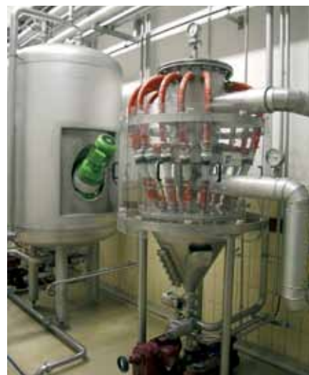
A sinistra, serbatoio di stoccaggio per i cristalli di tartrato; in primo piano una centrifuga Venturi
